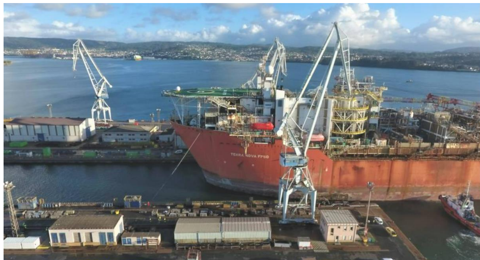
Reparación da plataforma Terra Nova en Navantia, Ferrol (Fonte: Navantia, 2022)
